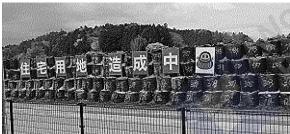
フレコンバッグの山に「住宅用地造成中」
